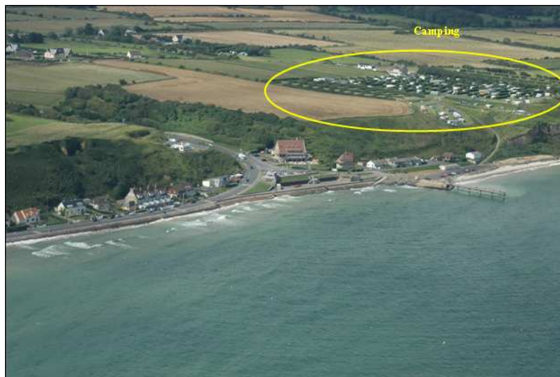
Figure 23 : Photographie aérienne du littoral de la commune de Vierville-sur-Mer en 2008. (Extrémité Est de la ZPS)
