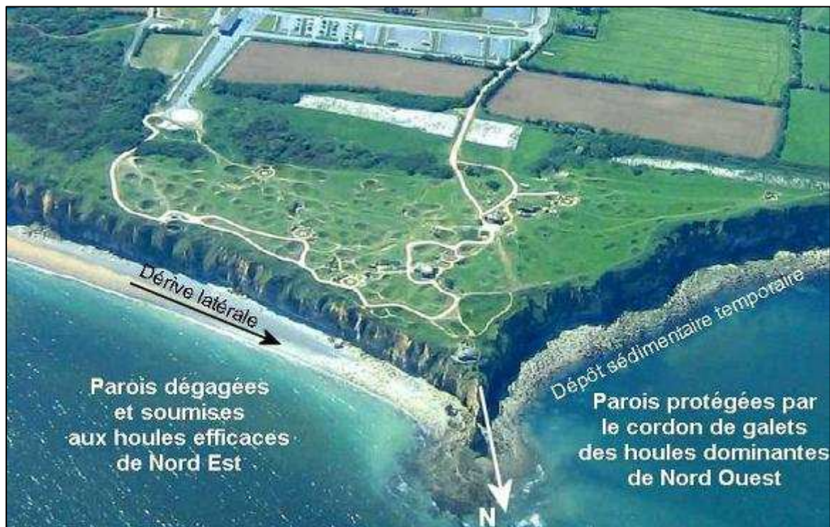
Figure 10 : Aspects dynamiques à la base de la falaise de la Pointe du Hoc.
