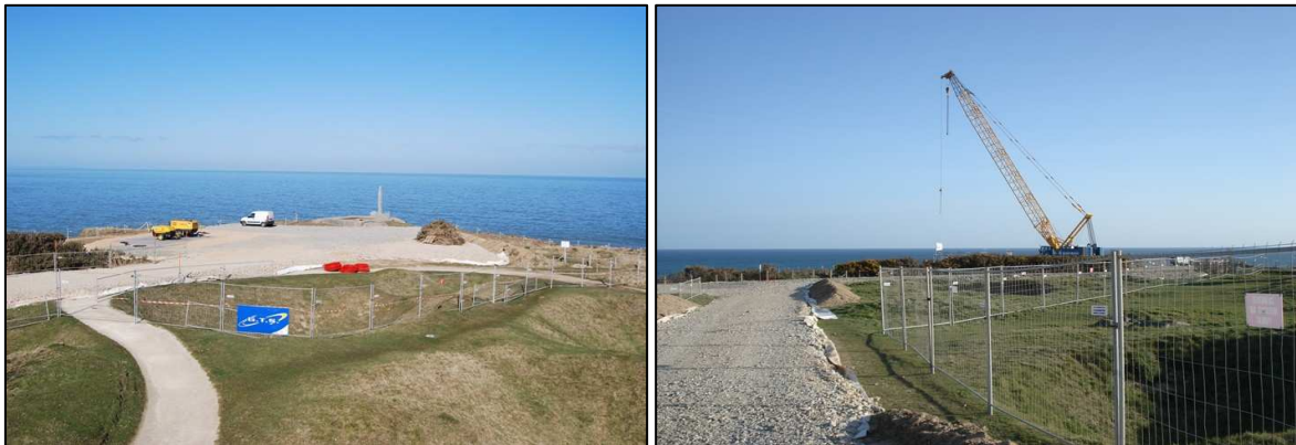
Figure 15 : Photographies du chantier de la pointe du Hoc au commencement des travaux. (En février et avril 2010)
