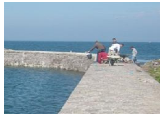
Illustration 12 - Iles Saint-Marcouf : phase de travaux sur l'île de terre en septembre 2011 (N. Hamon CRPMEM BN)
