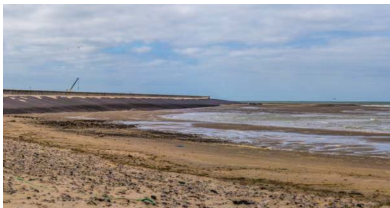
Plate-forme sableuse nouvellement créée au pied de la digue de Ruytingen
